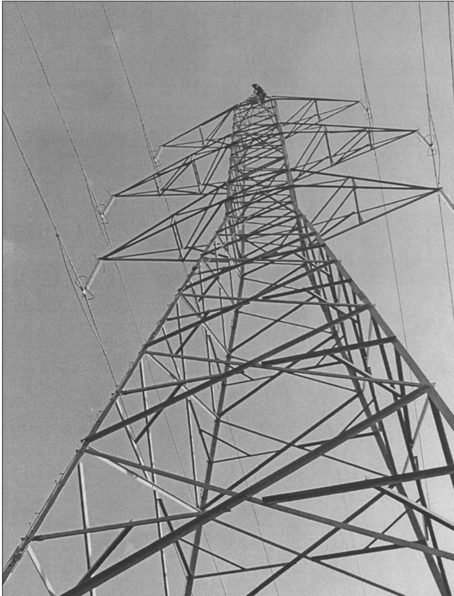
Figura 1.16.1.2. Inspección del apoyo 13
