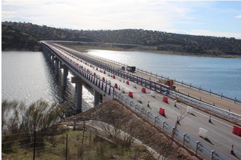
Nuevo puente construido junto al antiguo
