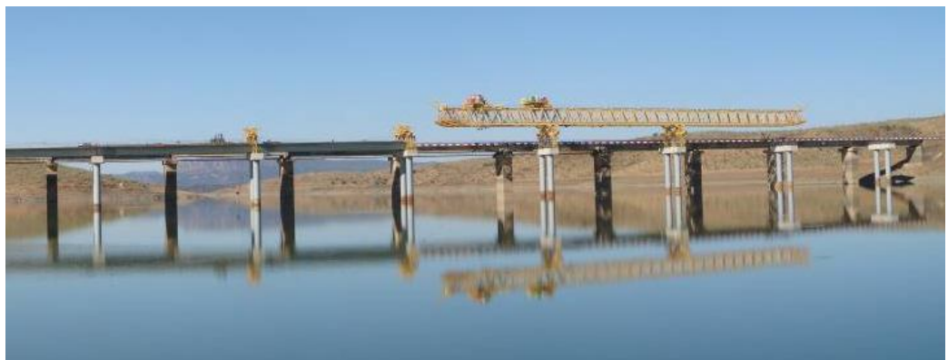
Nuevo puente en construcción: carro de lanzamiento de vigas
