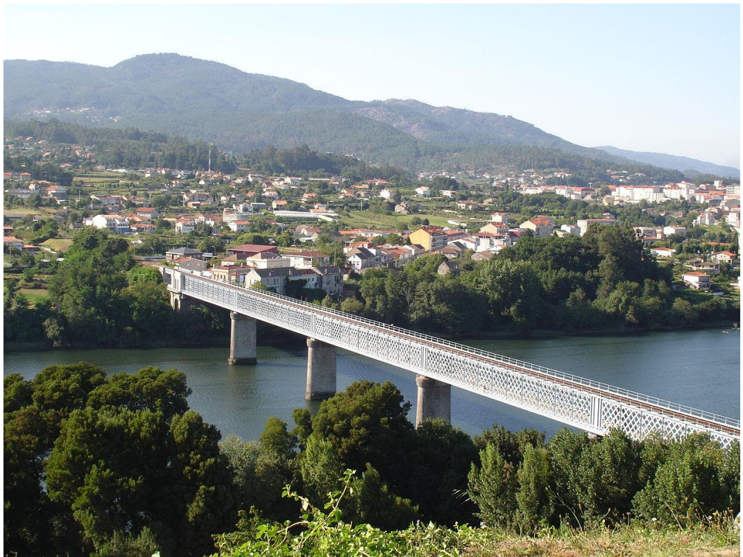
Antiguo puente internacional sobre el Miño entre Tui y Valença
