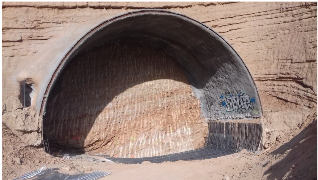
Trabajos de sostenimiento emboquille lado Olesa
