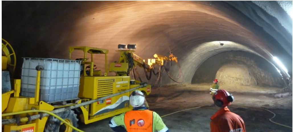
Trabajos de gunitado del túnel
