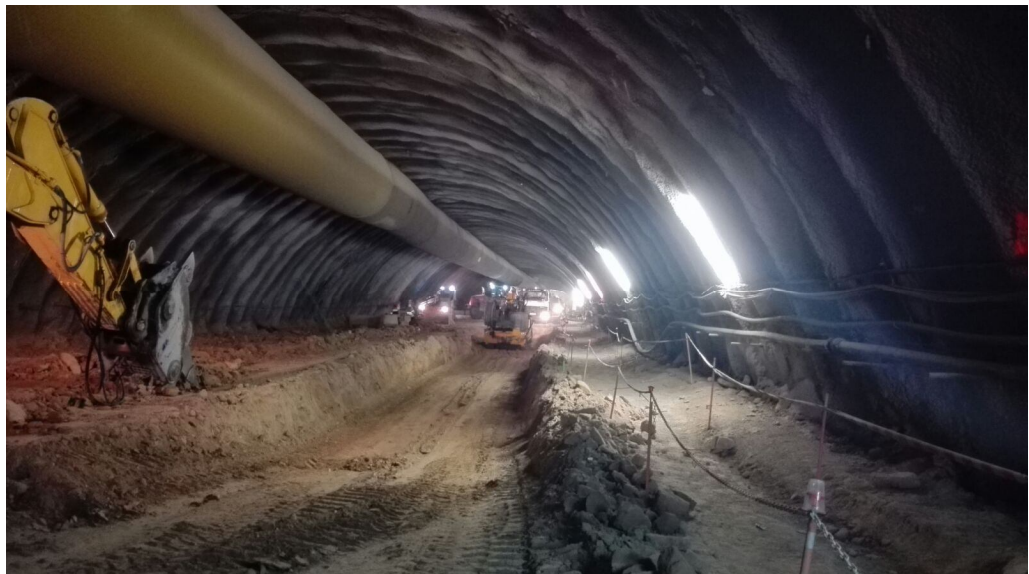
Trabajos de excavación de la destroza 1 del túnel
