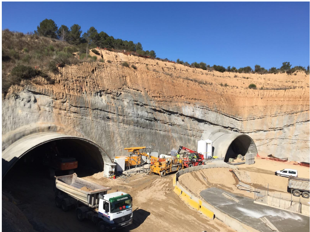
Trabajos en las bocas del túnel
