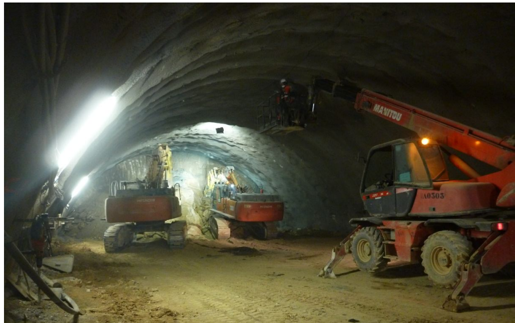
Trabajos de excavación del túnel
