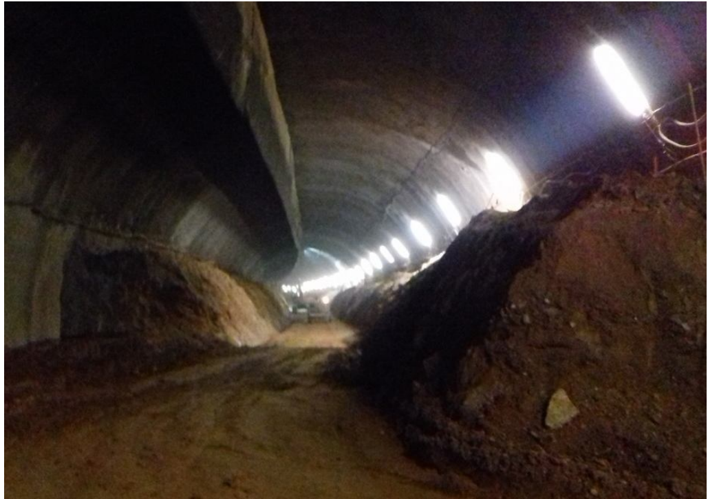
Trabajos de excavación y sostenimiento de la destroza 2 del túnel
