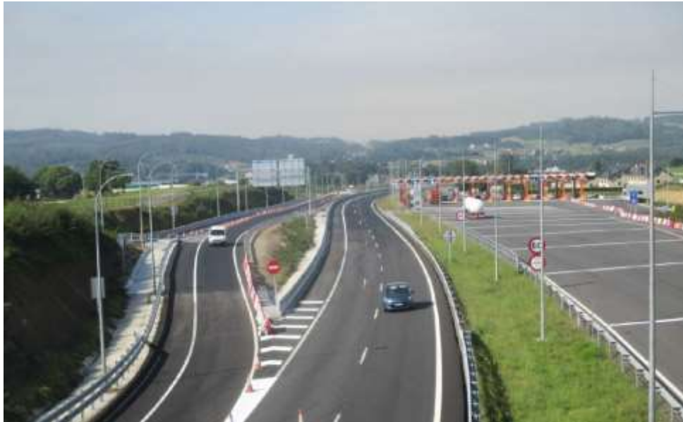
Fotografía 1: A la izquierda, nuevos ramales sentido Sur. A la derecha, playa de peaje ampliada.
