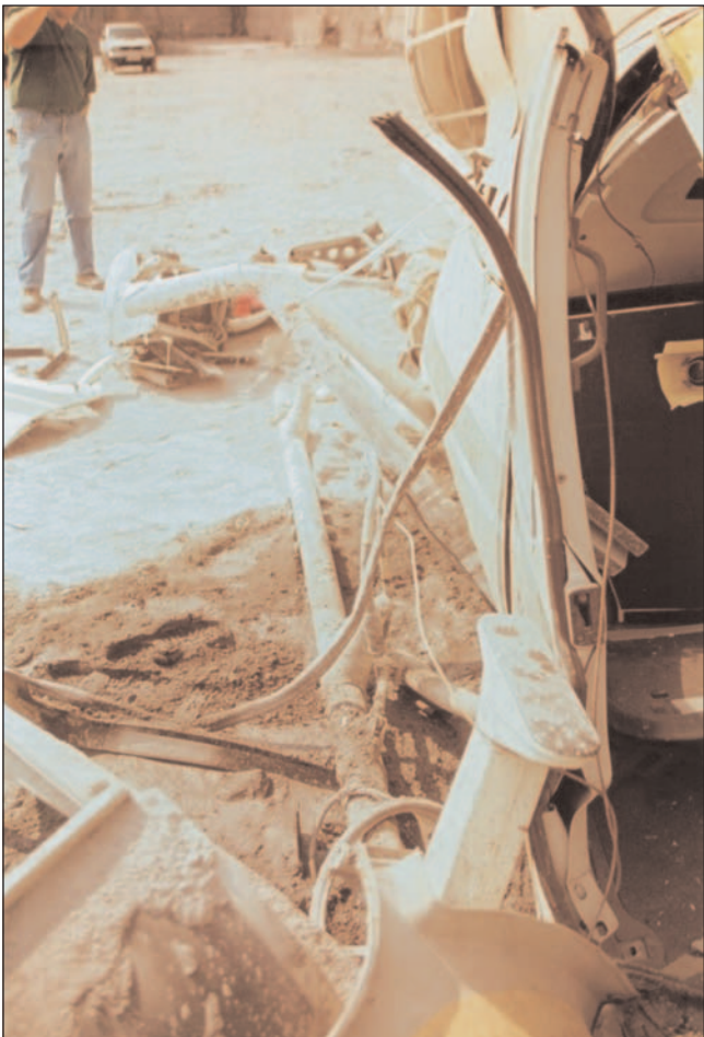
Detalle 2. Cable enganchado en estribo
