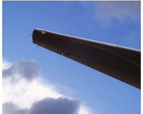
Figura 2.- Daños en aeronave D-ABAZ
