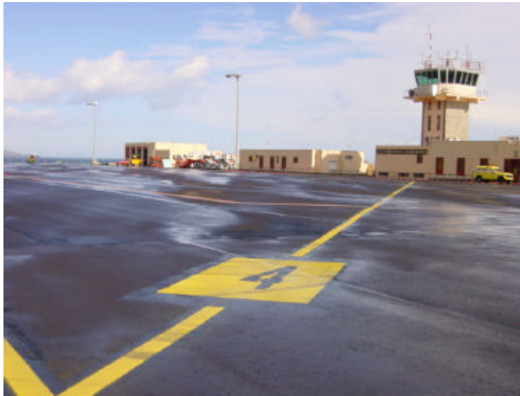
Figura 4.- Señalización posición de aparcamiento nº 4
