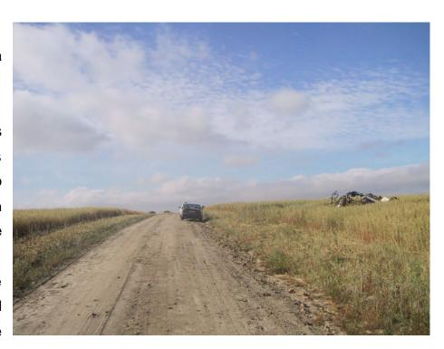
proporciona una anchura total de 10 metros (6 m. de pista más 4 m. de las dos franjas), aunque la pendiente lateral presenta un fuerte cambio en la transición entre la vía y la finca colindante.
