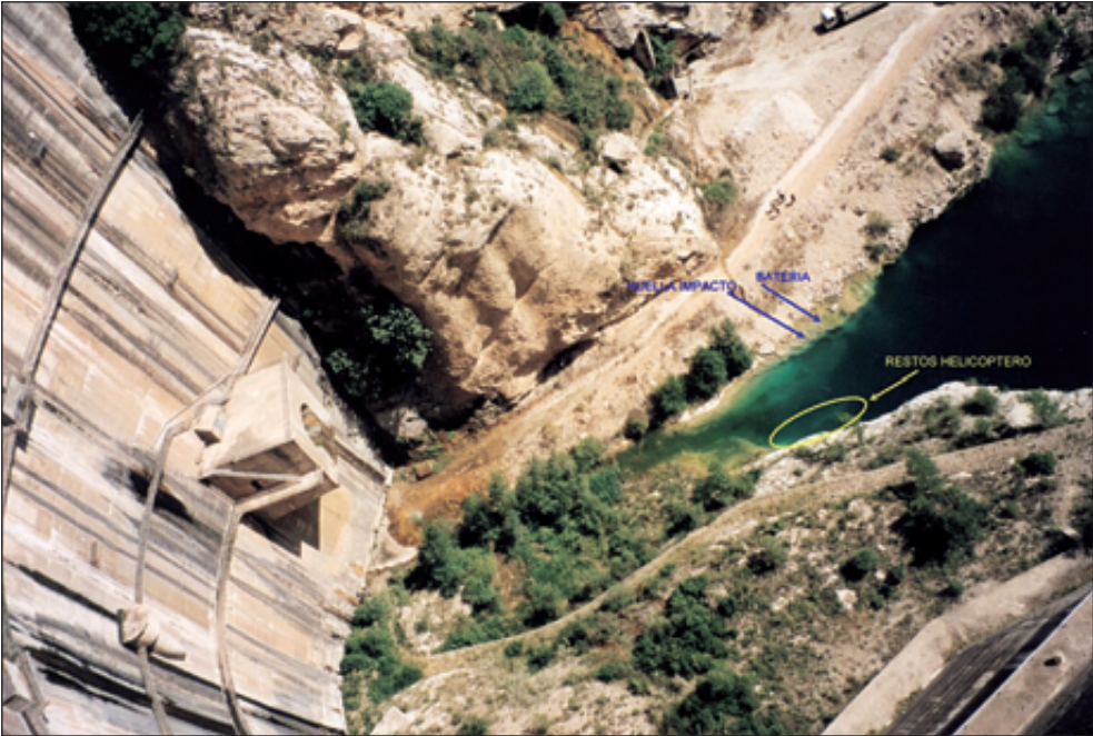
Figura 2. Vista desde la cima de la presa
