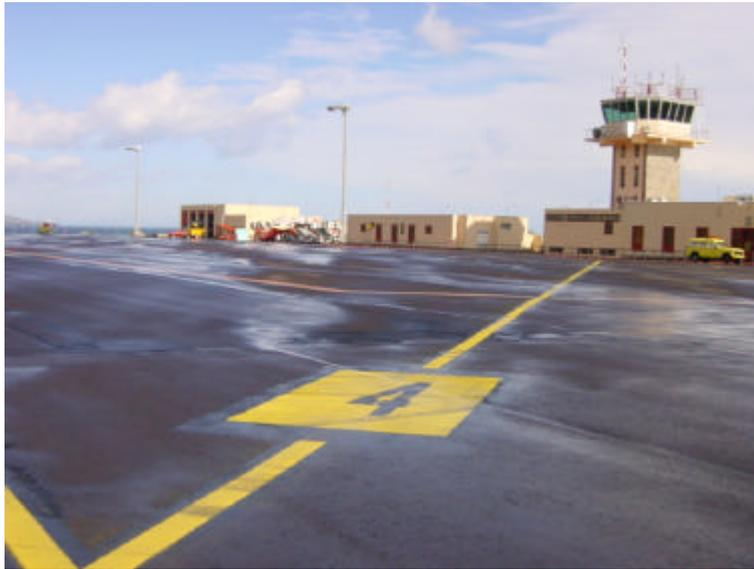
Figura 4.- Señalización posición de aparcamiento nº 4
