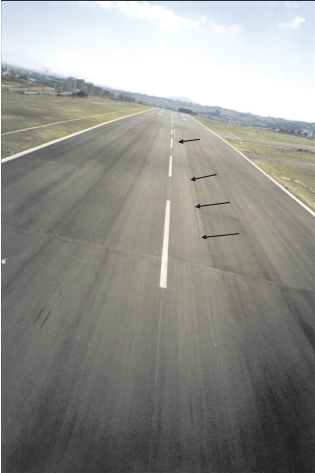
Foto 2. Vista en el sentido del aterrizaje. La huella de la rueda 3 cruza el eje de la pista
