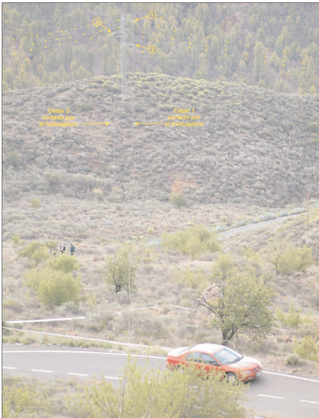
Figura 1.16.4. Torre inferior. El cable 2, remarcado con puntos amarillos, quedó indemne. Los cables laterales también están marcados con puntos amarillos para mayor claridad
