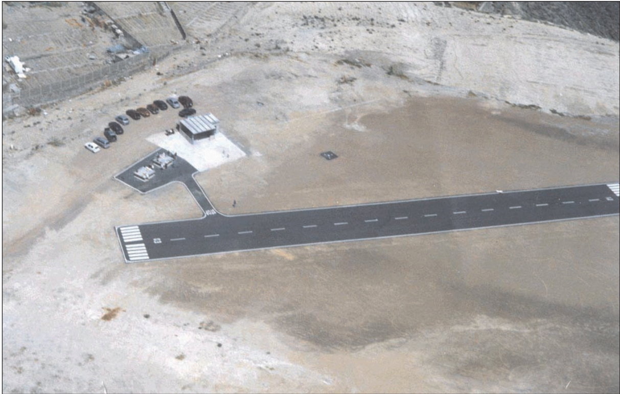
Figura A-4. Vista aérea de la pista de aerodelismo de Los Giles
