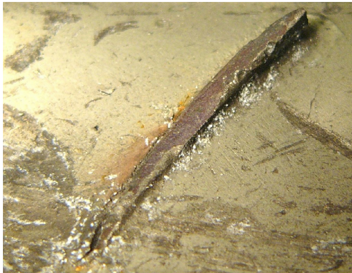
Figura 9. Rotura del álabes por fatiga
