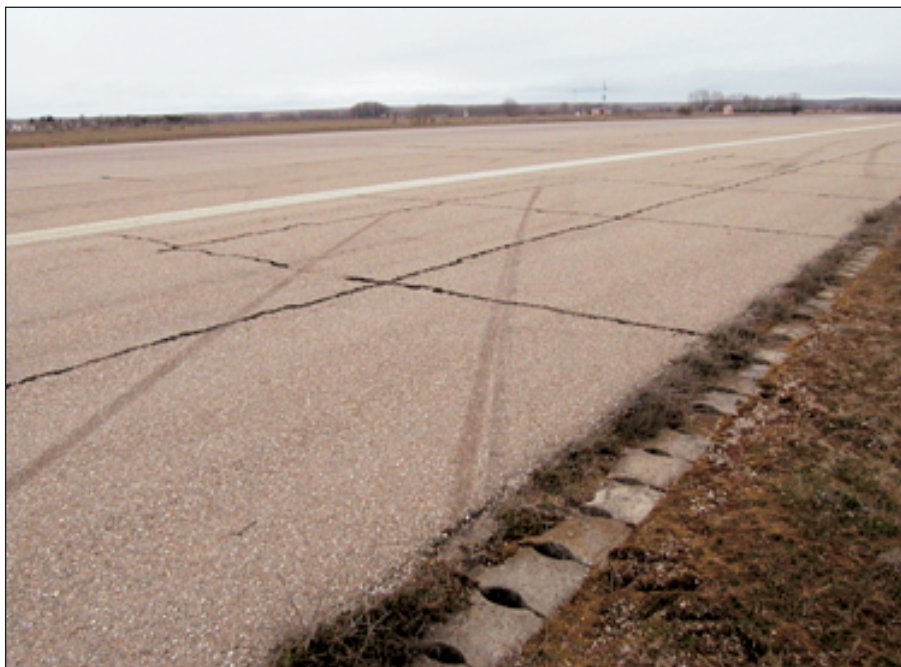
Figura 1. Huellas sobre el margen de la pista
