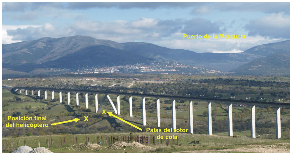
Figura 4. Fotografía del viaducto Arroyo del Valle
