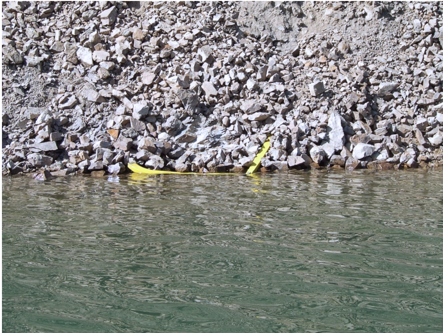
Figura 2. Huellas del impacto y restos desprendidos
