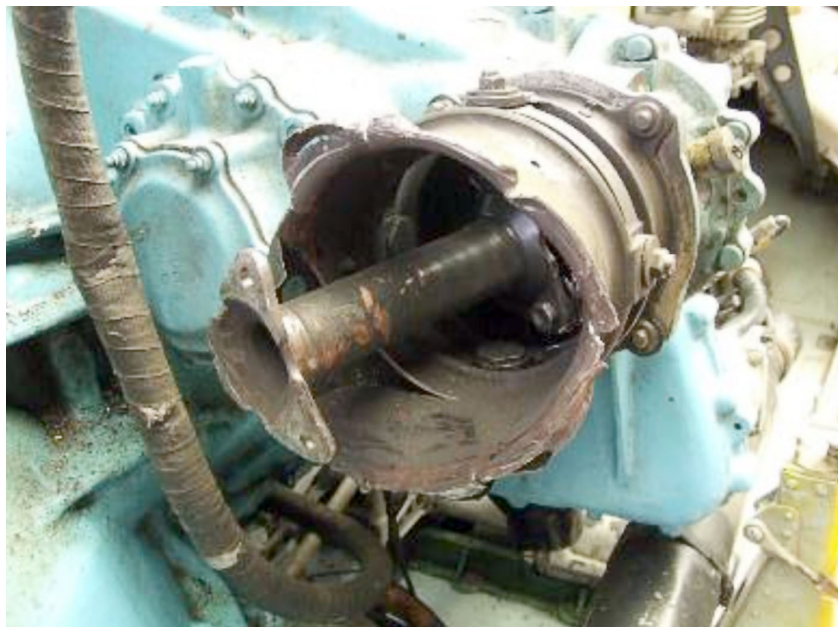
Figura 10. Eje intermedio desacoplado del de salida de turbina del motor 1. Alrededor se observa el «mounting cone» roto por los fragmentos de acoplamiento flexible proyectados. Al fondo, de color azul, está la caja combinada
