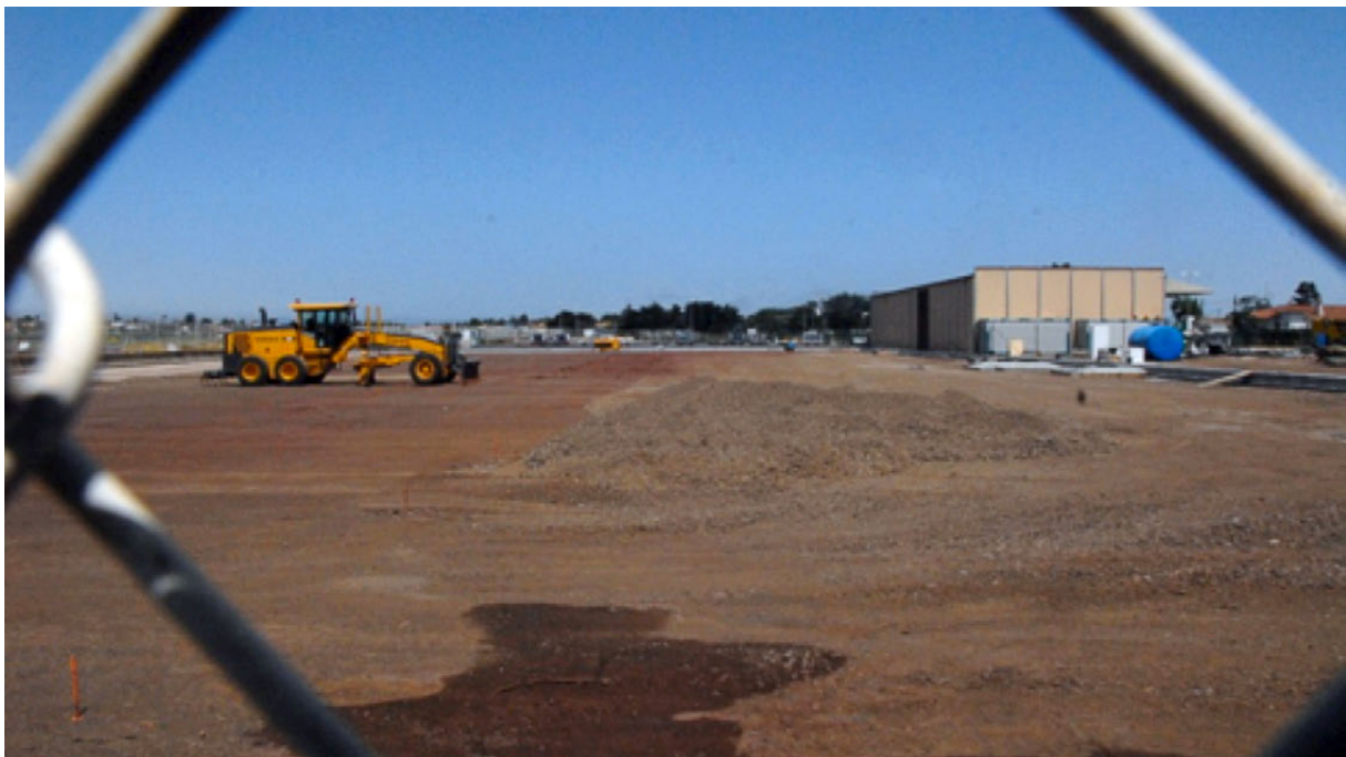
Figura 4. Obras en el recinto anexo al aparcamiento habitual de la aeronave
