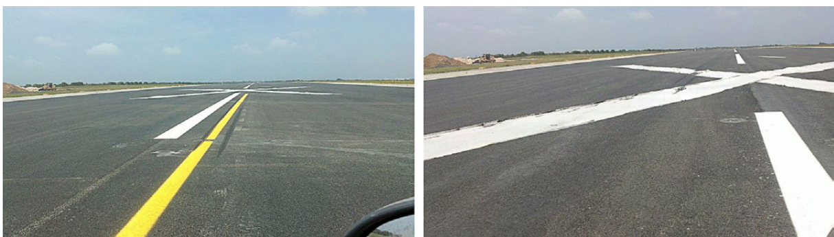
Figura 2. Toma de contacto con el tren derecho y después con el izquierdo a la altura del aspa n.º 4
