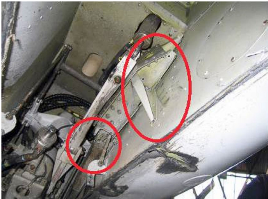
Figura 3. Pozo del tren delantero. Se observa la zona de fractura y la pérdida de remaches de la viga de sujeción del brazo de arrastre
