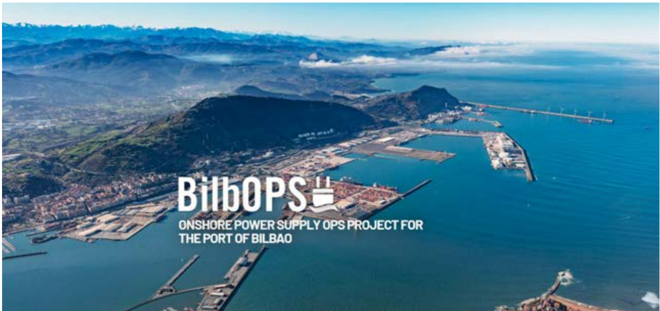
BilbOPS para el suministro de energía eléctrica en los atraques de los buques del Puerto de Bilbao.
