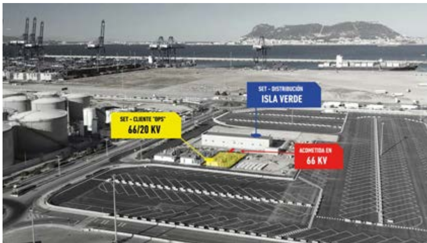
Subestación Eléctrica Isla Verde en Algeciras. Fuente: Google Earth.
