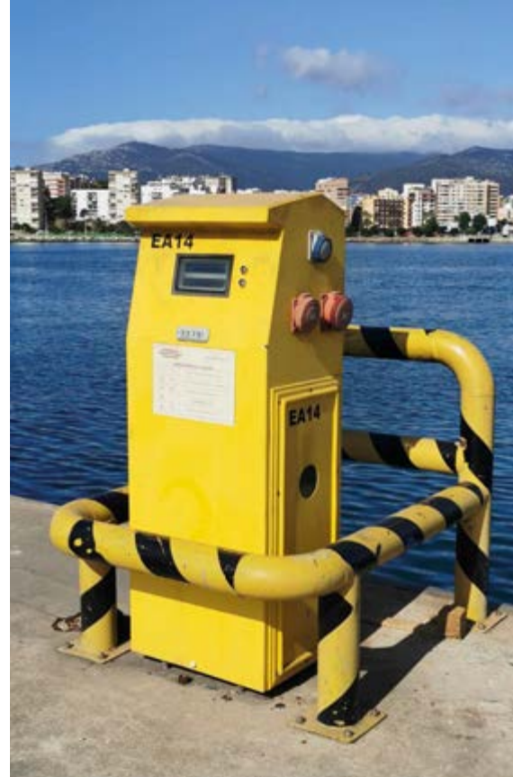
Bloque suministro agua y electricidad. Fuente: Autoridad Portuaria de la Bahía de Algeciras.
