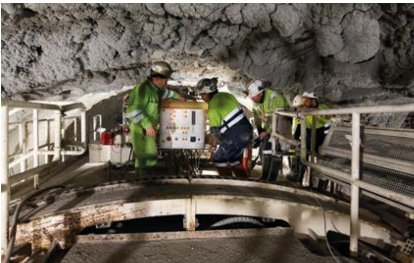
El reducido espacio de trabajo entre la bóveda del túnel y la máquina.
