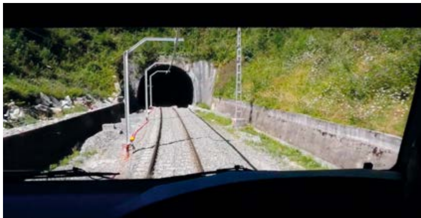
Boca del túnel de Gaintxurizketa, ya con vía única.
