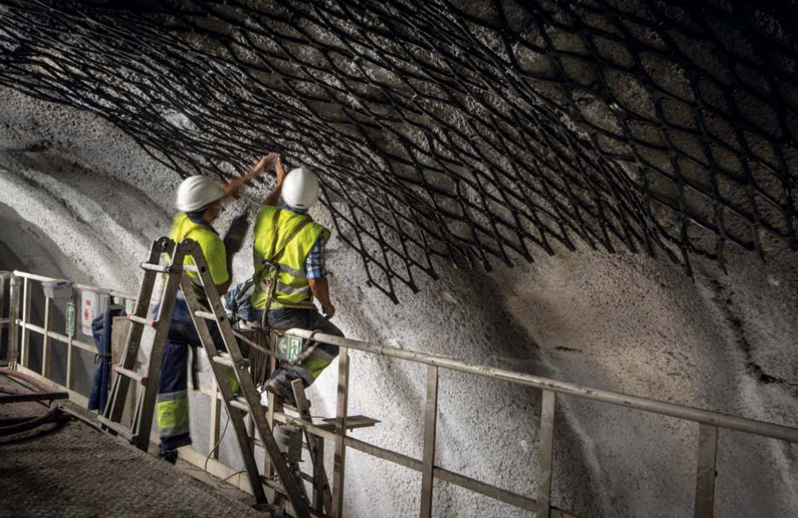
Trabajos de sostenimiento en la superficie ampliada del túnel.
