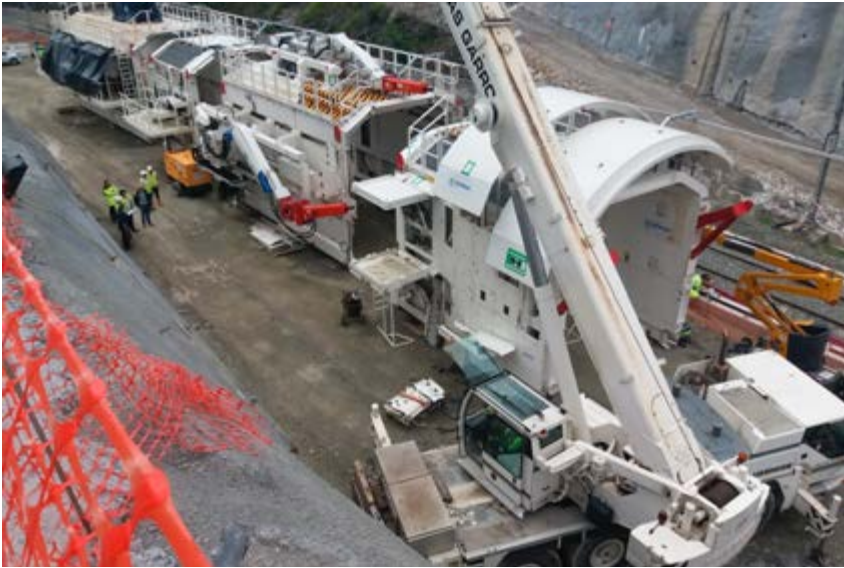
Montaje de la D835 en el exterior del túnel, en 2018.
