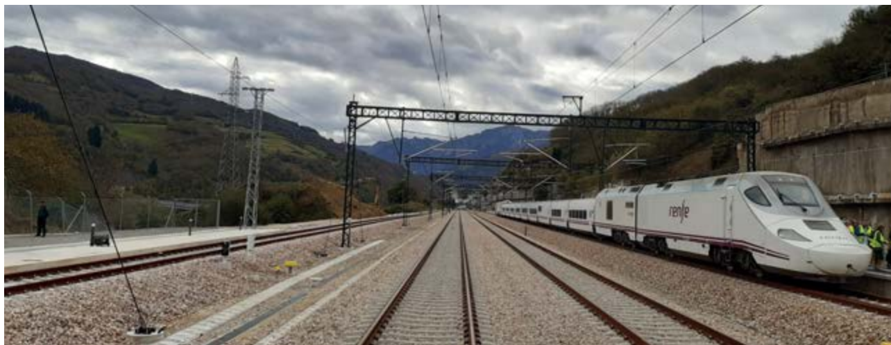
Tren S-730 estacionado en el PAET de Campomanes.
