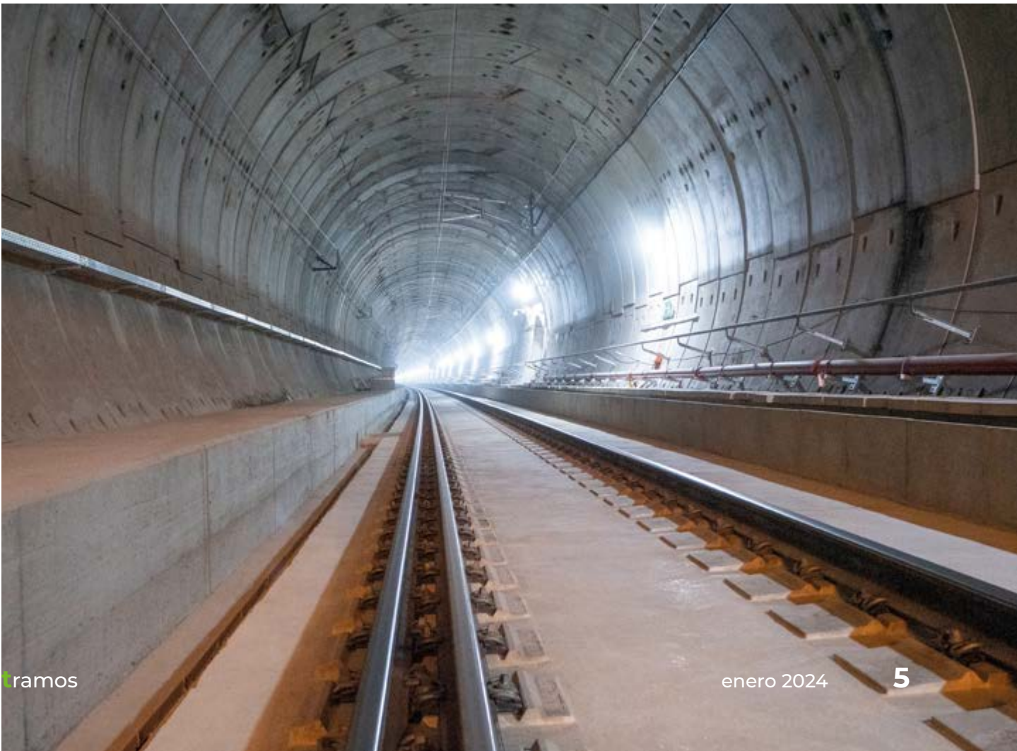
Tercer hilo (ancho mixto) en el tubo este del túnel de Pajares.
