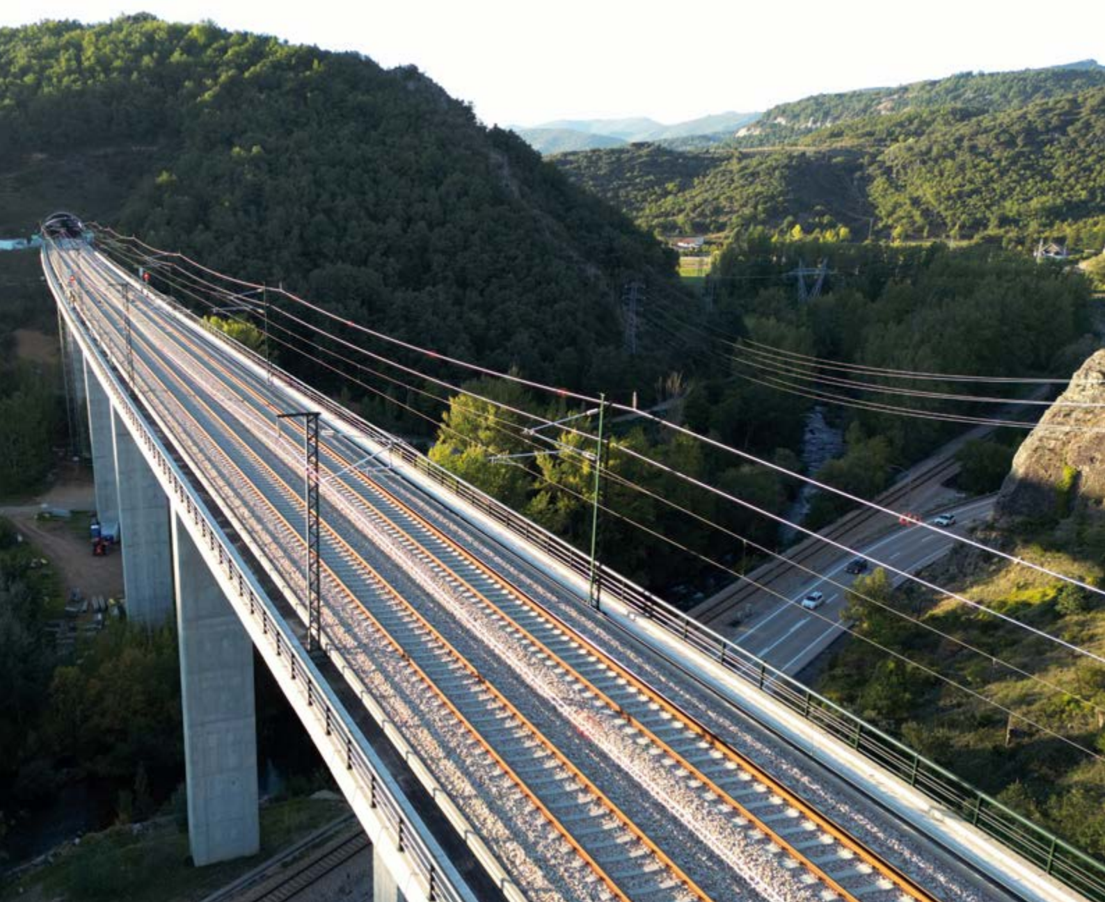
Viaducto de Huergas, de 396 m de longitud y 43 m de altura, sobre la N-630 y la línea existente y túnel del Buen Suceso II.
