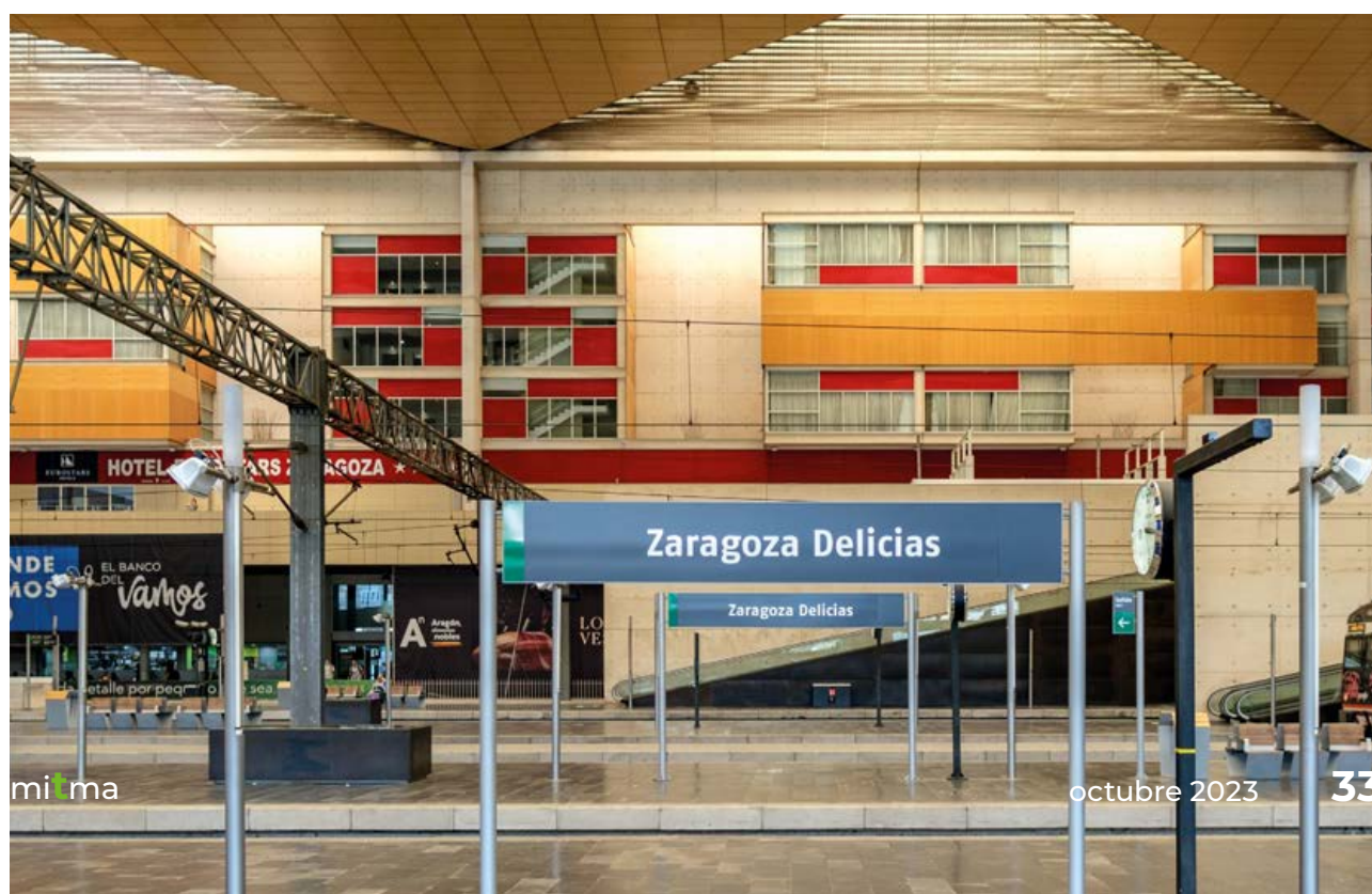
Detalle de los andenes de la estación.
