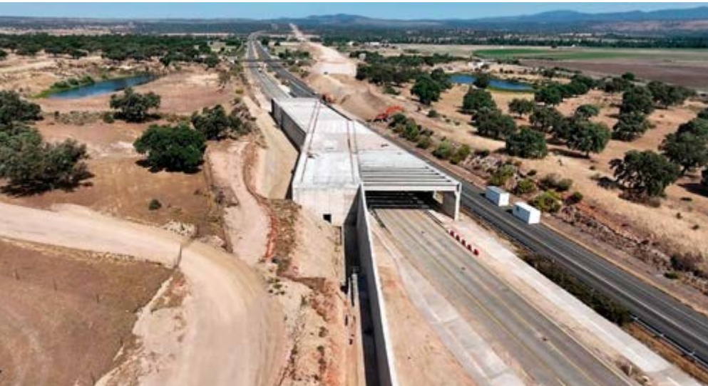
Obra de la pérgola sobre la autovía EX A1, en el tramo Toril-Río Tiétar.
