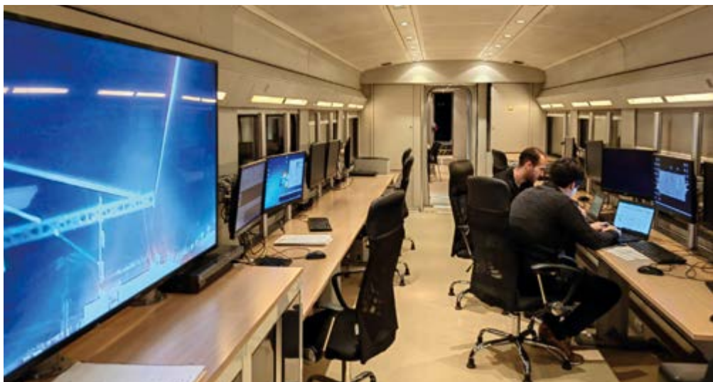
Pruebas de catenaria en el interior del tren laboratorio BT de Adif.
