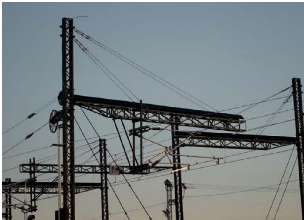
La catenaria instalada es el tipo C-350, típica de las nuevas LAV.
