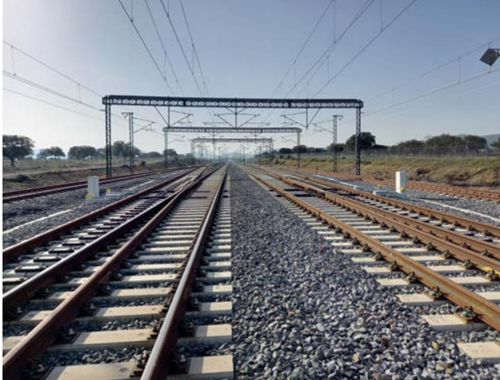
La catenaria instalada es el tipo C-350, típica de las nuevas LAV.
