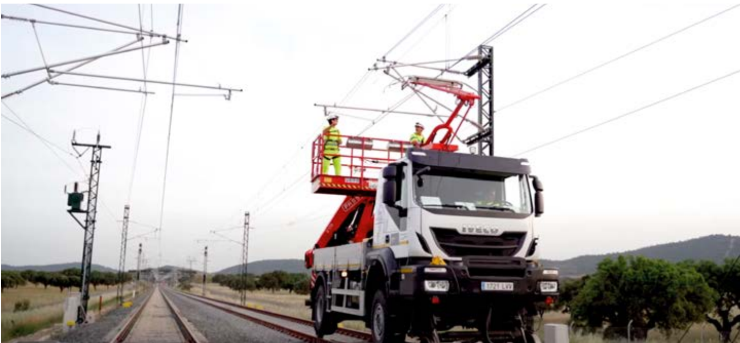
Labores de ajuste de la línea aérea de contacto.
