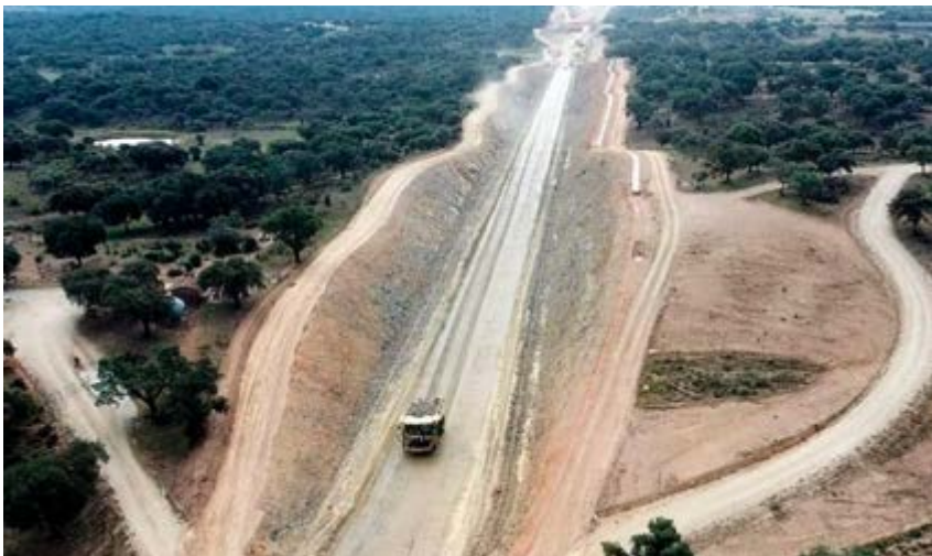
Vista del tramo Río Tiétar-Malpartida de Plasencia desde el p.k. 3+800 hacia Navalmoral de la Mata.
