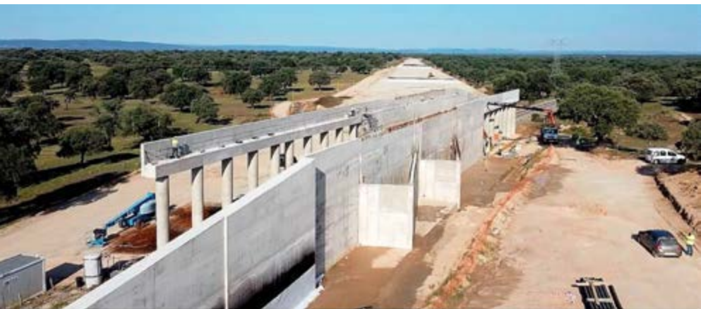
Ejecución de una estructura en el tramo Casatejada-Toril.
