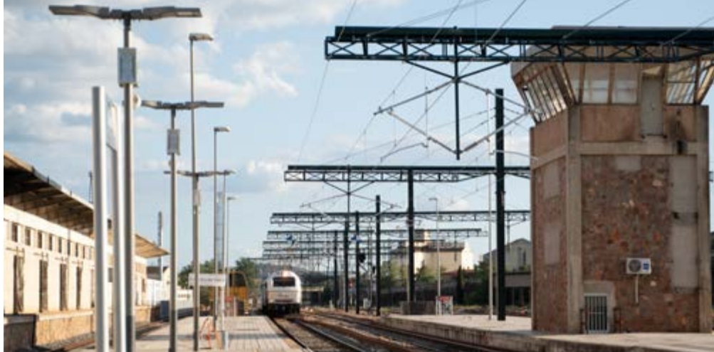
Pruebas de fiabilidad de la catenaria en la estación de Cáceres.
