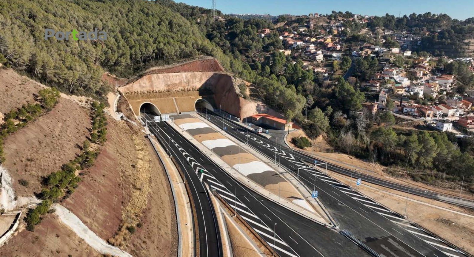
Boca oeste y edificio del centro de control del túnel.
