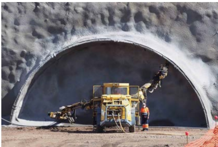
De arriba abajo, secuencia de la ejecución del emboquille de una de las bocas del túnel.
