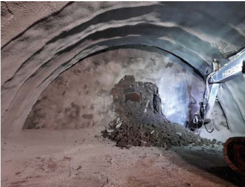
Cale del tubo oeste el pasado 15 de agosto (sobre estas líneas) y cale del tubo este el pasado 26 de junio (debajo).
