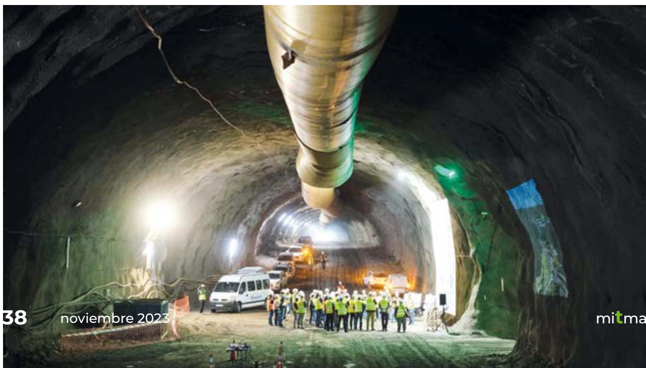
Sección de túnel finalizada durante una visita de las autoridades de la isla.
