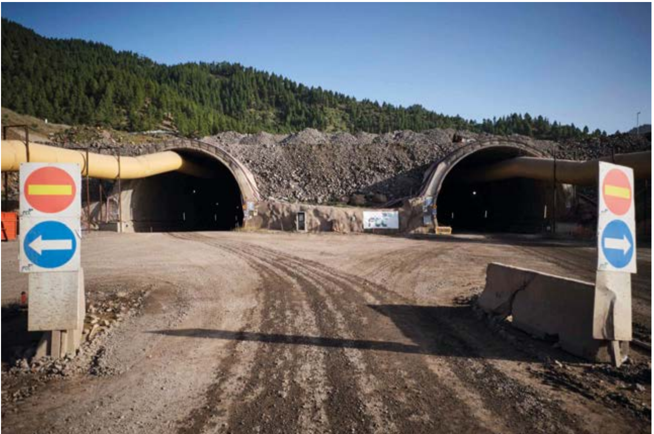
Boca sur del túnel de Erjos, en el término de Santiago del Teide.
