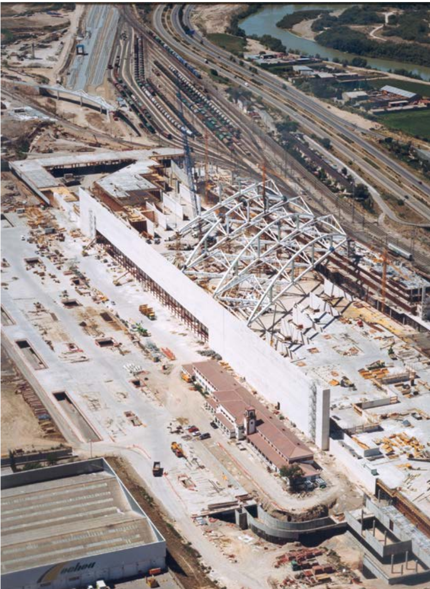
Vista aérea de la construcción de la estación intermodal.
