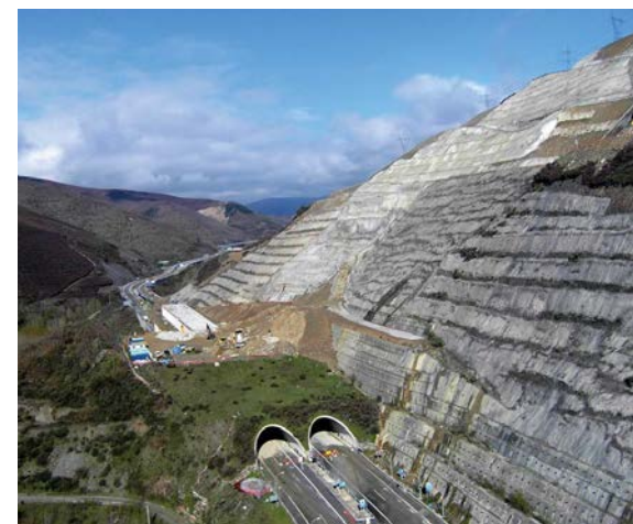
Vista del talud de Trabadelo.
