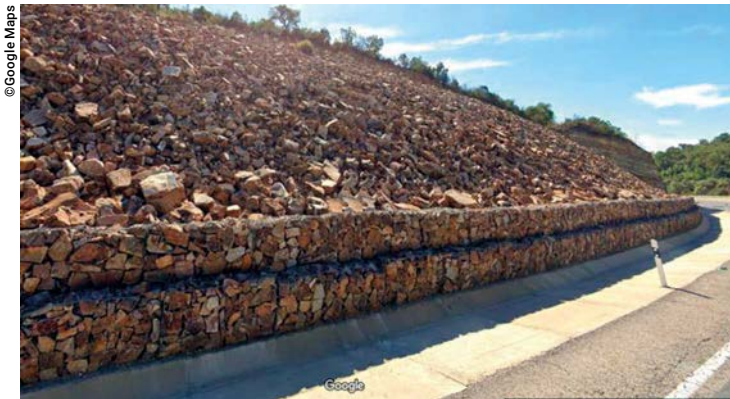
Vista de la escollera de Fuencaiente.
