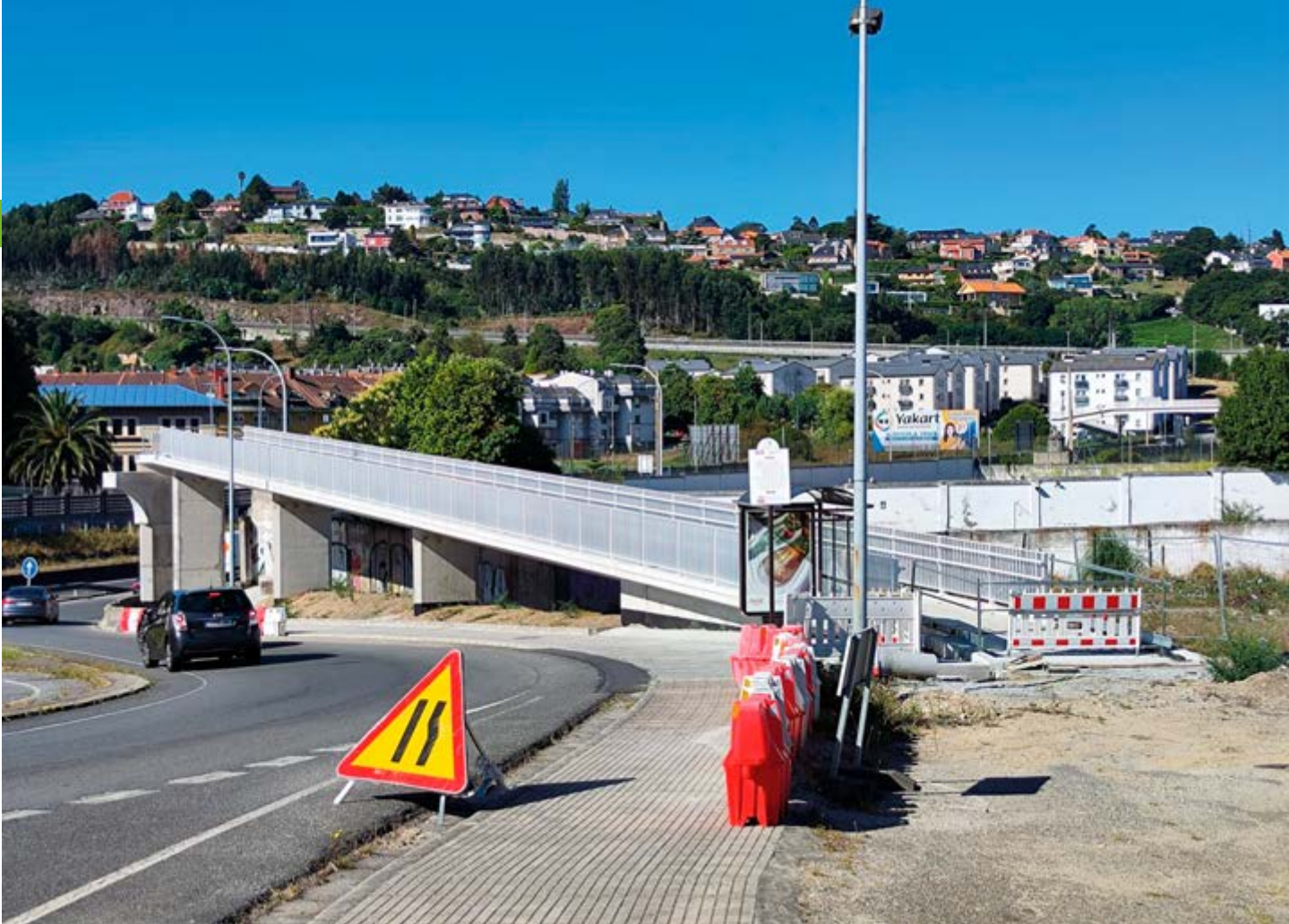
Obras de Pedralonga.
