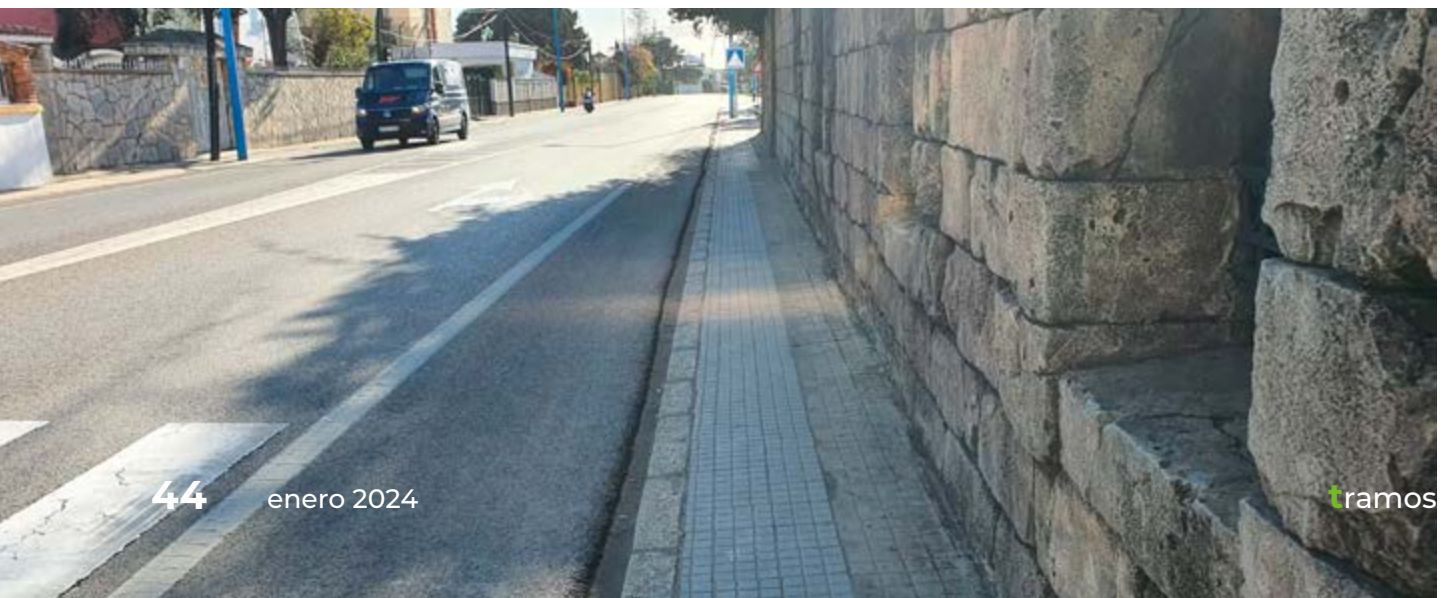
Actuación de humanización en la travesía de Campamento.
