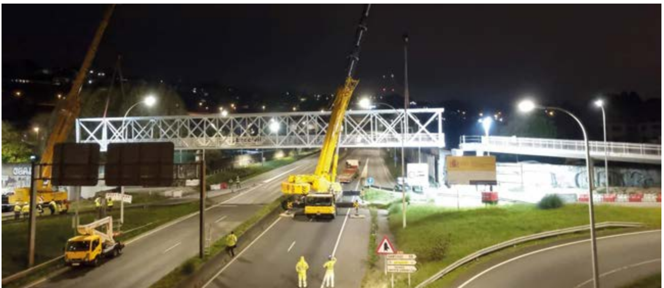
Montaje de la pasarela de Pedralonga.
