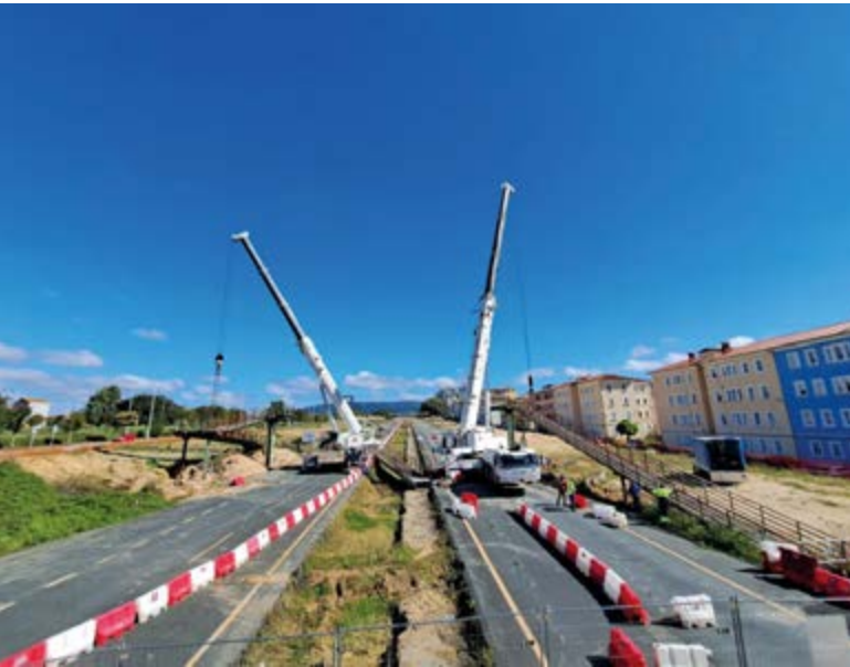
Obras de humanización de la FE-14 en Ferrol.
