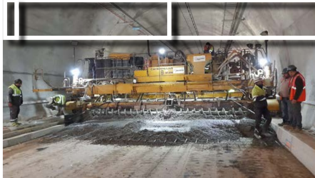
Construcción del pavimento de hormigón en el interior del túnel.
