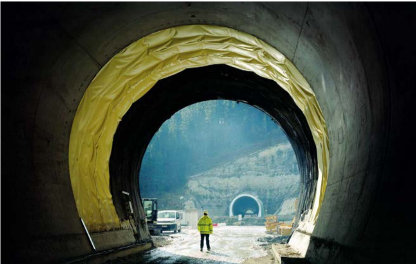
Túnel de Karraskain visto desde el túnel de Udalaitz.
