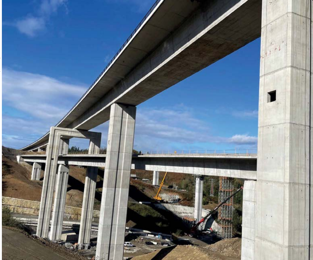
Los viaductos de Zabaleta y Zabaleta Sur materializan el cruce de dos ejes del nudo.
