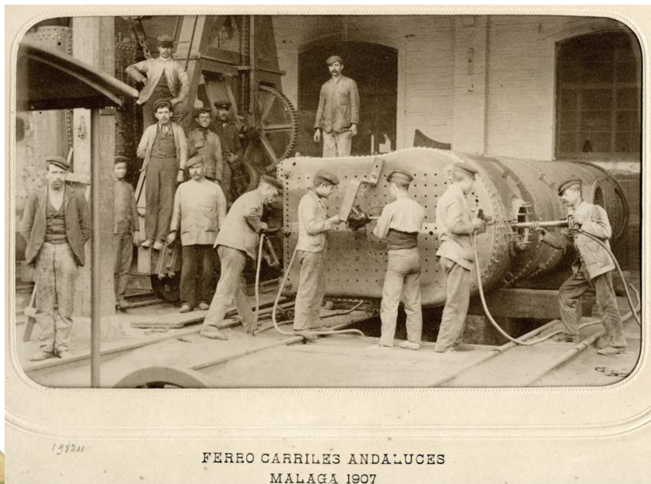
Personal de los talleres de la Compañía de los Ferrocarriles Andaluces realizando trabajos de remache con herramientas de presión neumática en la caldera de una locomotora de vapor (1907). Autor Jules David Cavaz.
