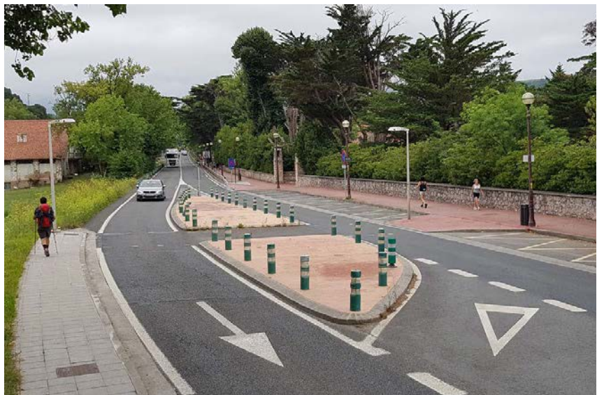
Cruce peatonal /ciclista sin prioridad sobre carretera.
