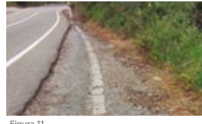
Figura 11 Carretera: N-630 Provincia: Sevilla Coordenadas: X: -6,184 Y: 37,676 Tipología: Encintado lateral y firme de macadam con riego. Circuito Nacional de Firmes Especiales (1926/1939).
