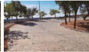
Figura 8 Carretera: Travesía transferida (N-III) Provincia: Cuenca Coordenadas: X: -2,798 Y: 39,919 Tipología: Adoquinado con bordillos laterales. Curva peraltada en travesía. Circuito Nacional de Firmes Especiales (1926/1939).
