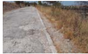
Figura 7 Carretera: CM-9513 (N-V) Provincia: Toledo Coordenadas: X: -4,376 Y: 40,059 Tipología: Firme de macadam con riego asfáltico superficial y encintado. Circuito Nacional de Firmes Especiales (1926/1939).
