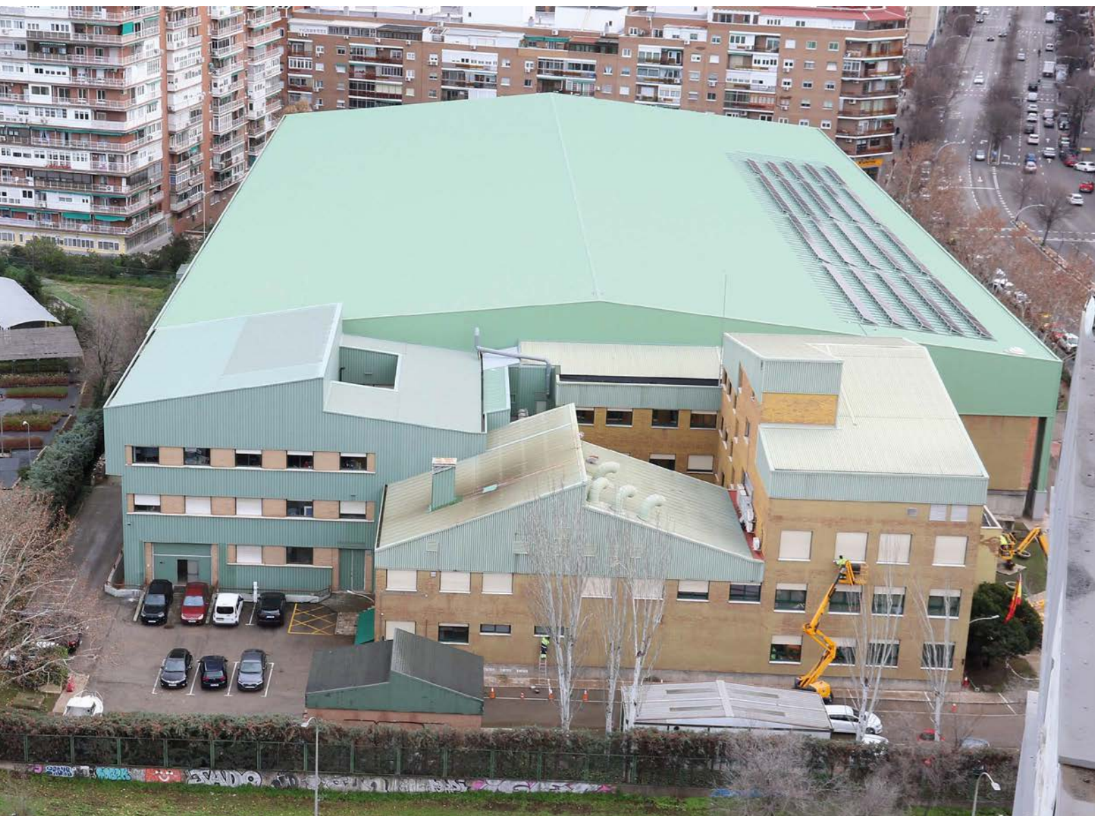
Vista general del CEPYC con la cubierta totalmente finalizada.
