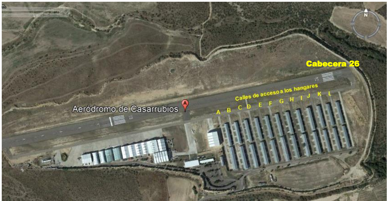
Figura 3. Vista general del aeródromo de Casarrubios del Monte
