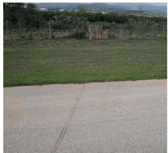
Ilustración 6 Marcas de freno en calle rodadura
