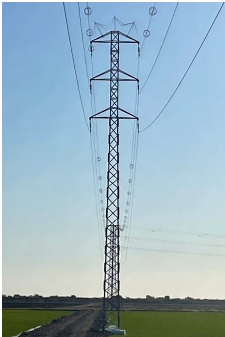
Figura 13 (izquierda): torre del tendido eléctrico más próxima al lugar del choque.
