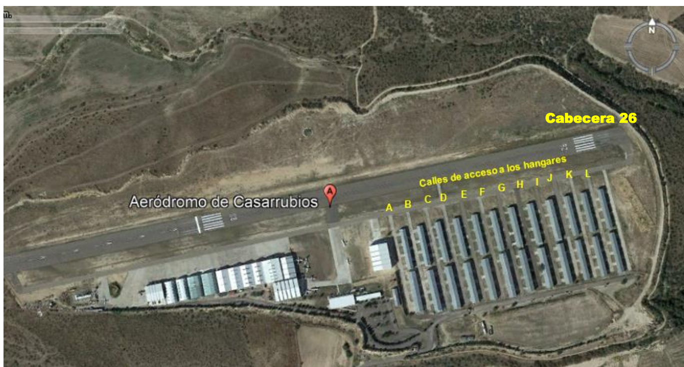
Figura 3. Vista general del aeródromo de Casarrubios del Monte
