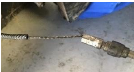
Fotografía 14. Detalle del descriptado del cable de actuación del mando de mezcla
