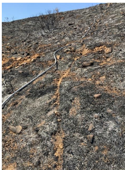
Fotografía 20. Tendido seccionado de la ladera sur
