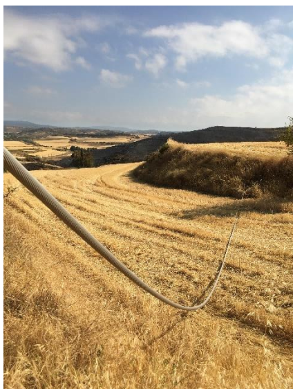
Fotografía 19. Tendido seccionado de la ladera norte
