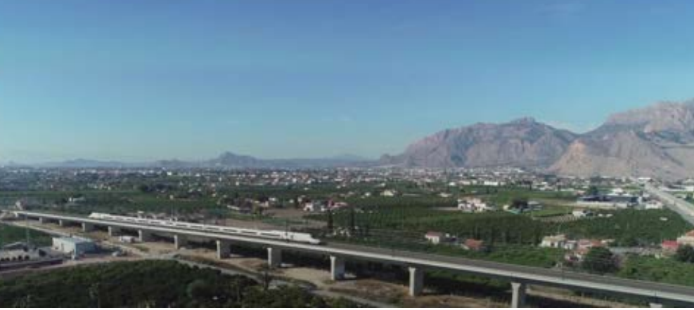
Sobre estas líneas y debajo, viaducto sobre el trasvase Tajo-Segura.
