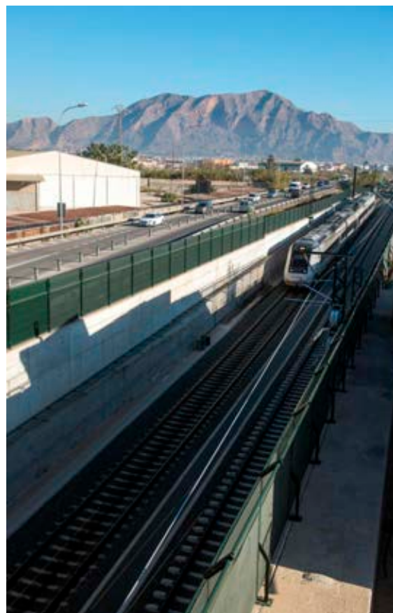
Rampa de soterramiento en la estación de Orihuela.
