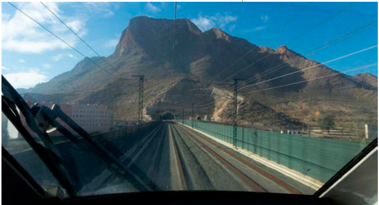
Túnel de Callosa.
