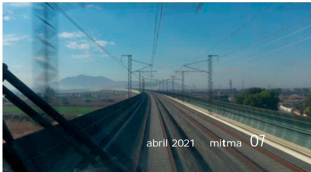
Viaducto sobre la AP-7.
