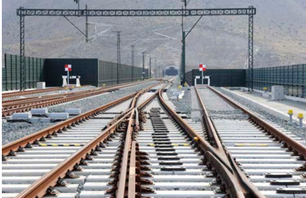
Playa de vías en la estación de Callosa.
