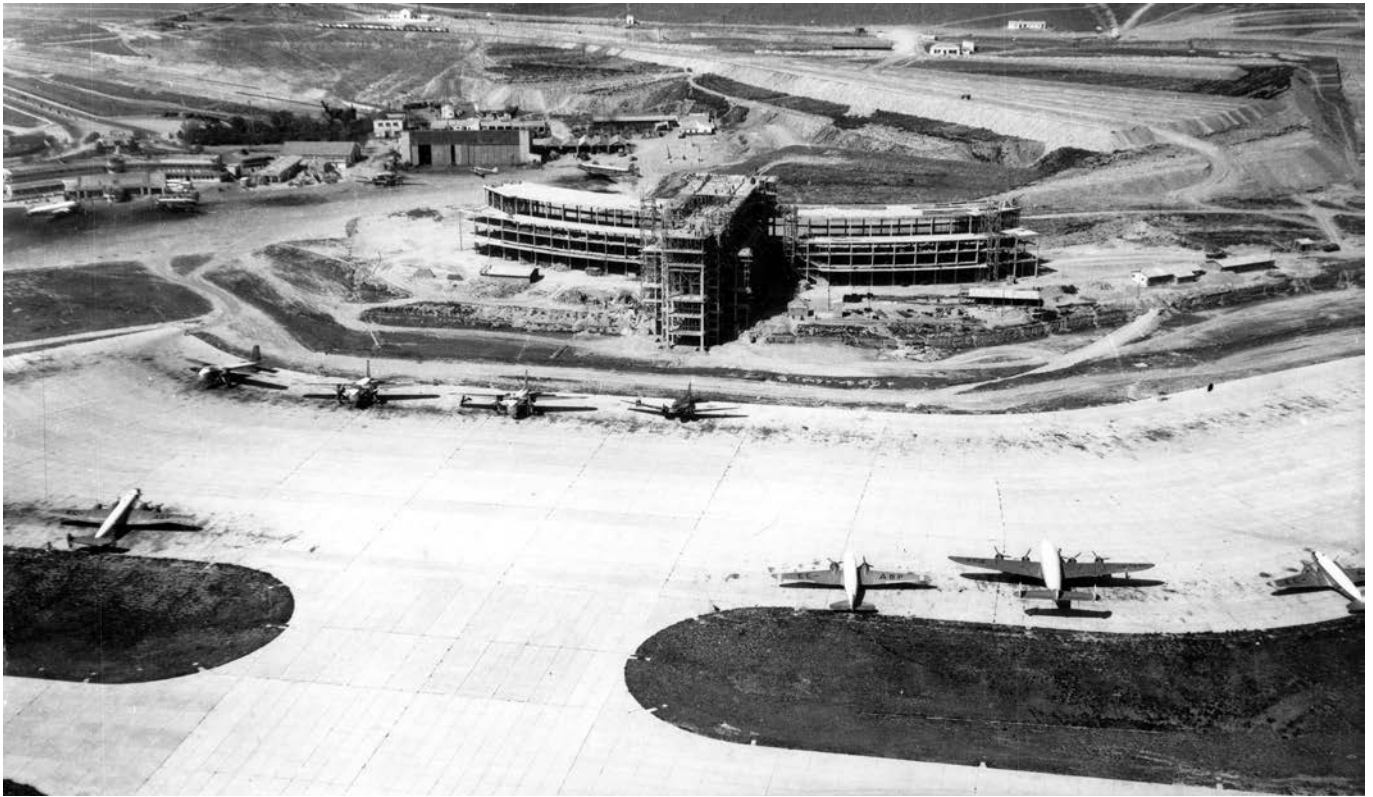
► Construcción de la nueva terminal nacional (hoy T-2) del aeropuerto de Barajas en 1954.
