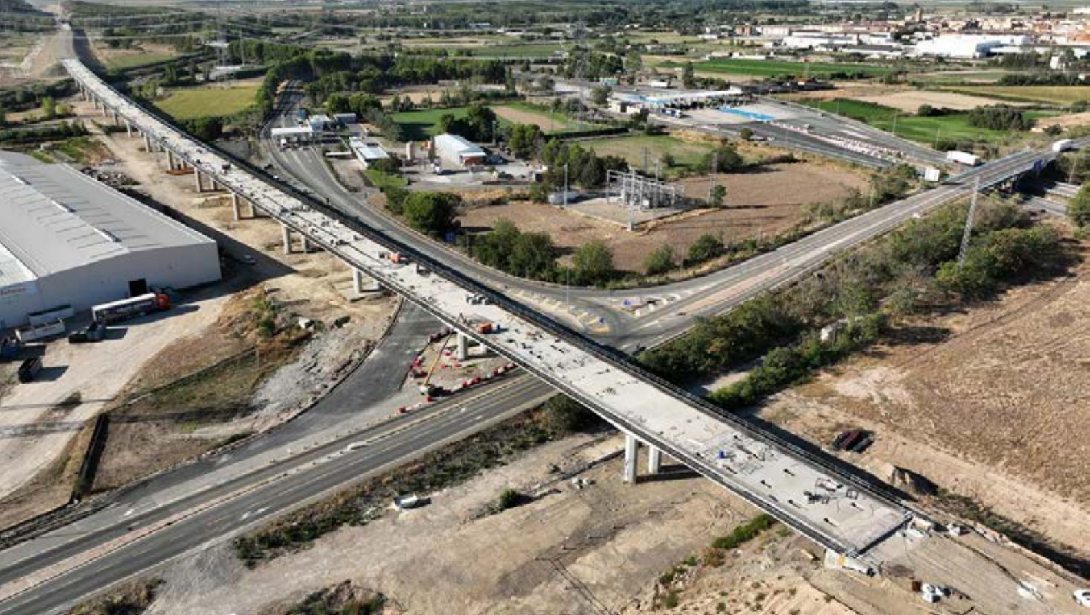
Con 854 metros divididos en 18 vanos, el viaducto de Marcilla es el de mayor longitud del tramo entre Castejón y Pamplona.
