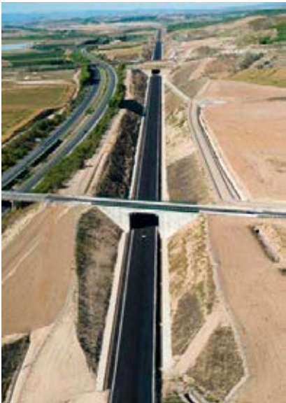
Plataforma terminada del tramo Castejón-Cadreíta.
