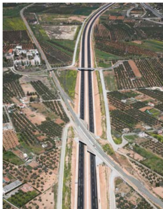
Paso inferior bajo el ferrocarril Almería-Granada.
