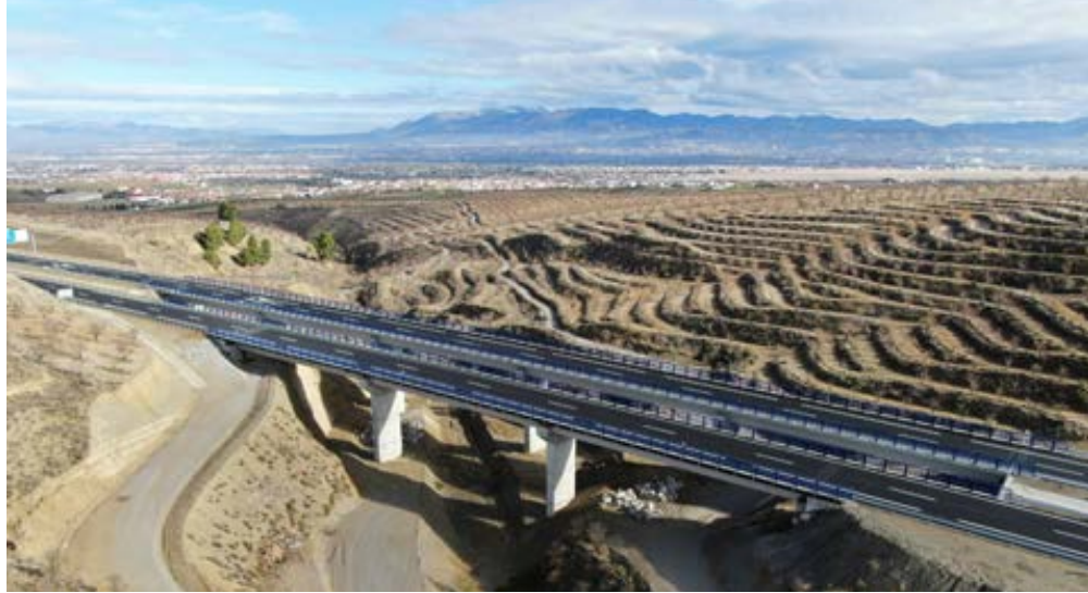
Viaducto de Cañada Honda.
