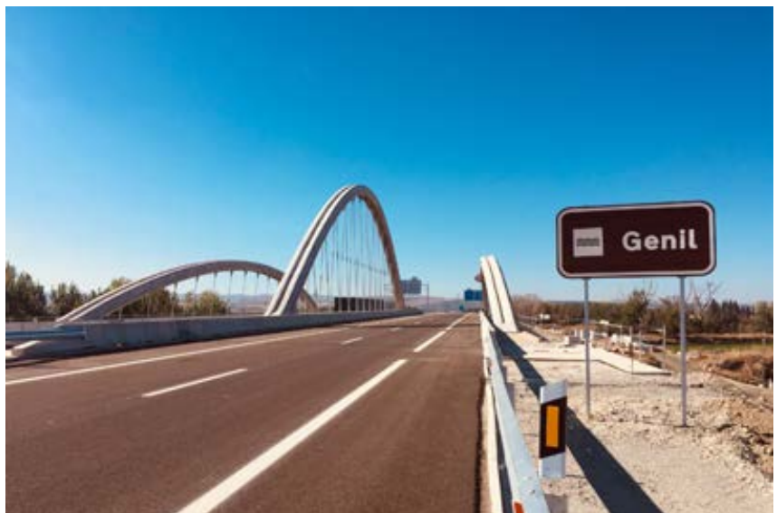
Viaducto sobre el río Genil.
