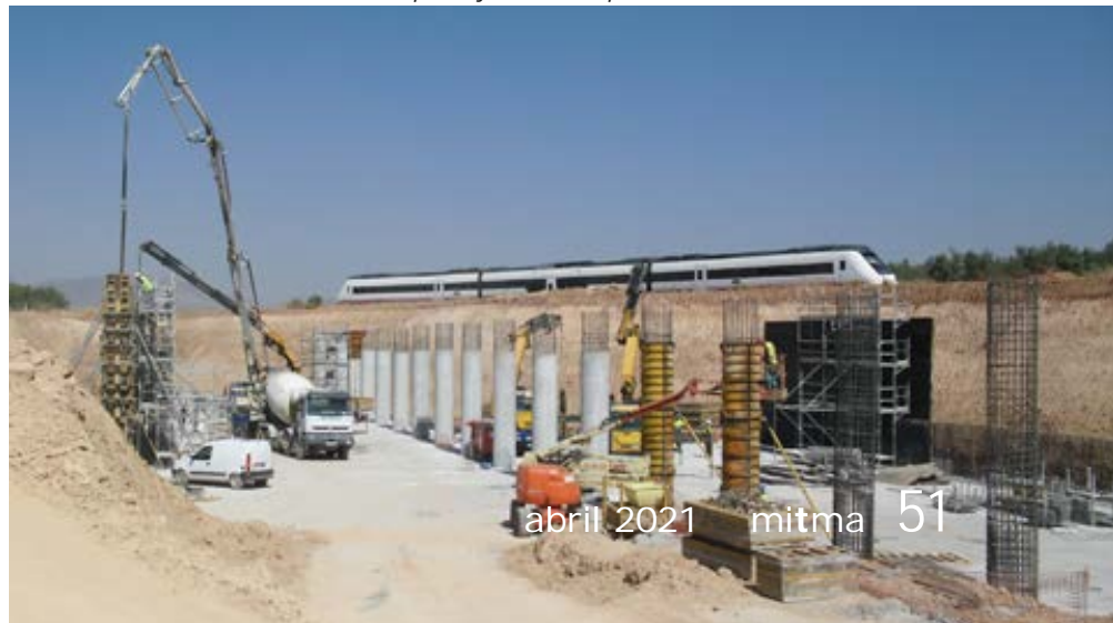
Desvío del ferrocarril Almería-Granada para ejecución del paso inferior.
