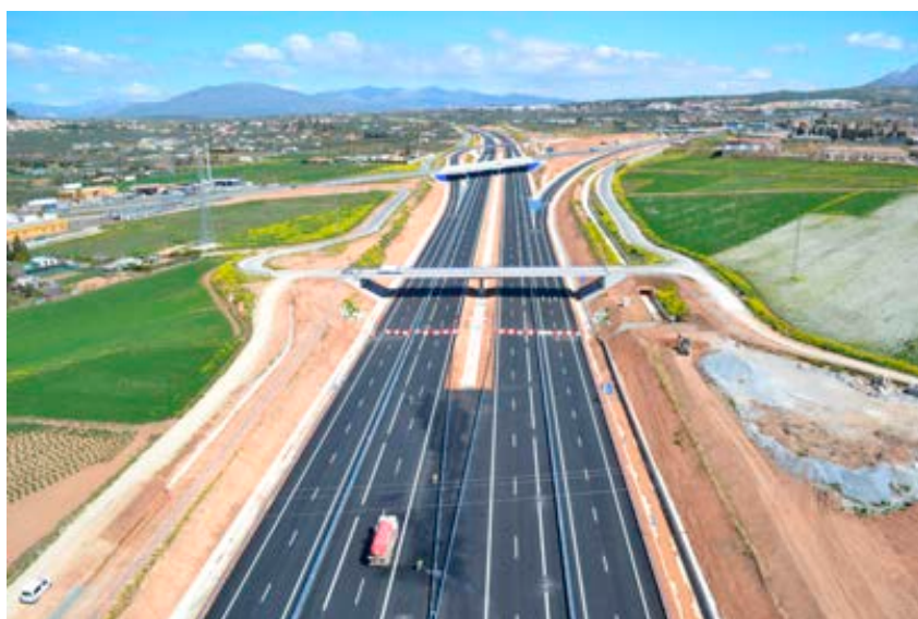
Inicio del Tramo 2.
