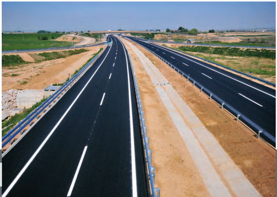
► Paso superior de reposición en la Cañada Real.
