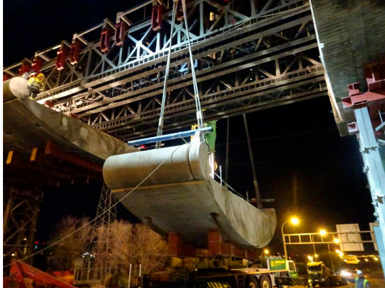
Descenso de secciones en tramo sobre M-40
