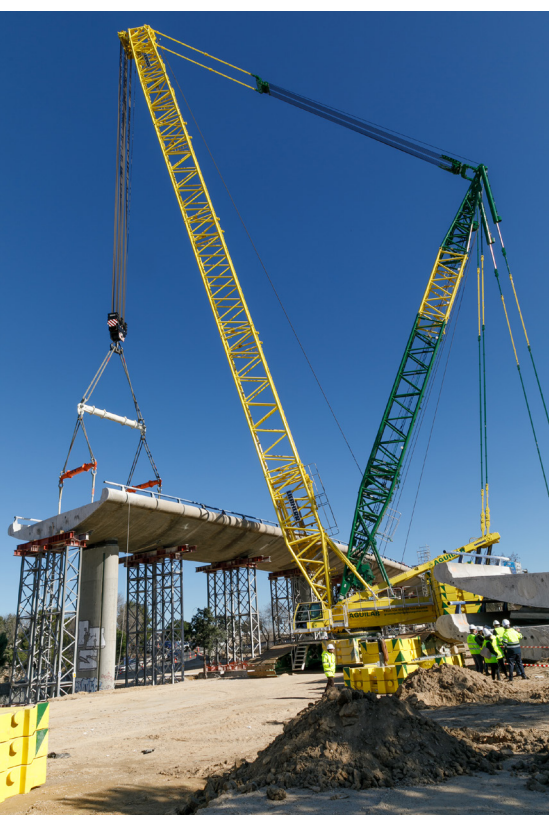
Retirada de las secciones con grúa
