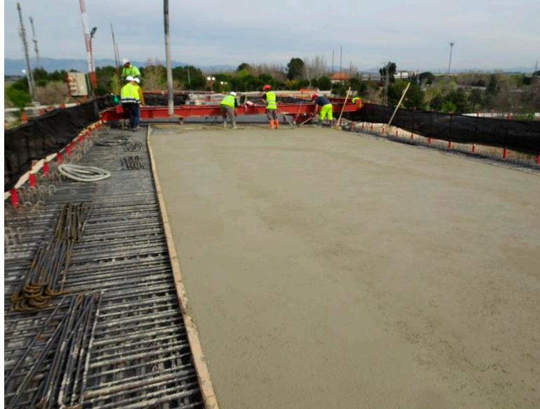
Hormigonado de losa in situ
