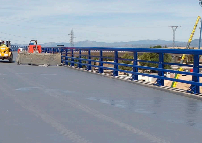
Impermeabilización con poliurea
