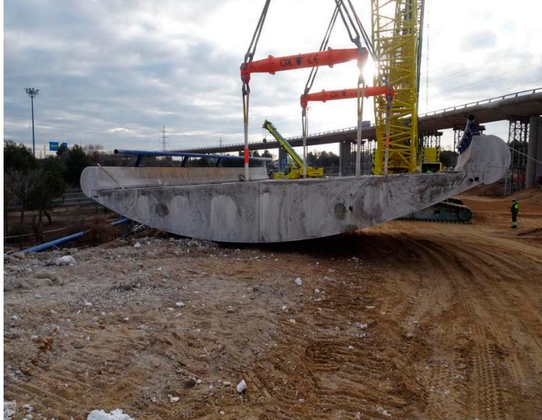
Acopio de las secciones
