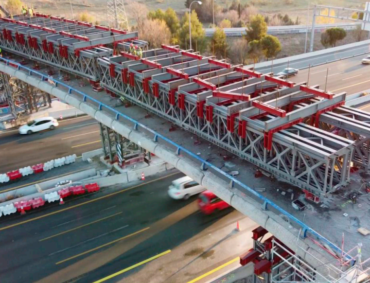
Celosía para el tramo sobre M-40
