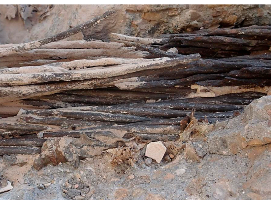
Corrosión y rotura del pretensado
