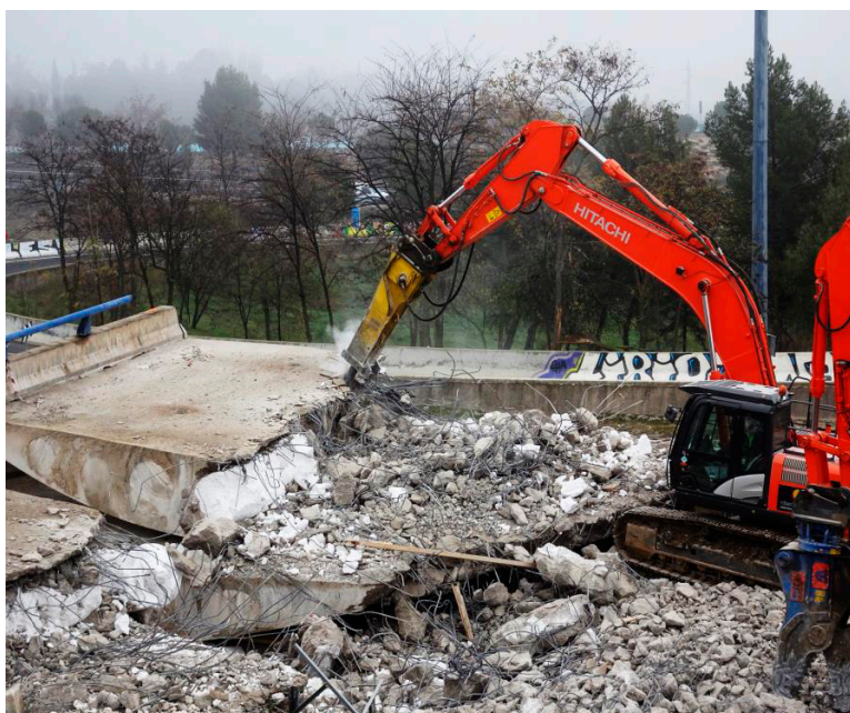
Picado de las secciones en la zona de acopio
