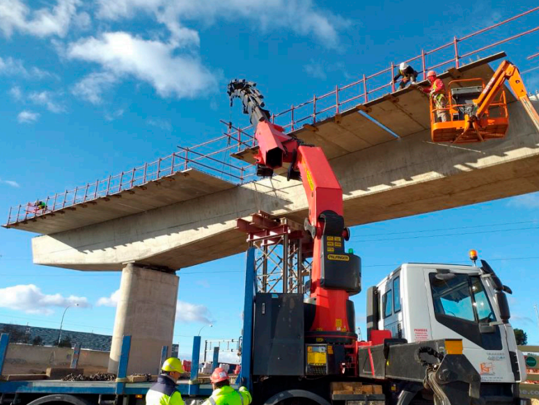
Montaje de prelosas prefabricadas
