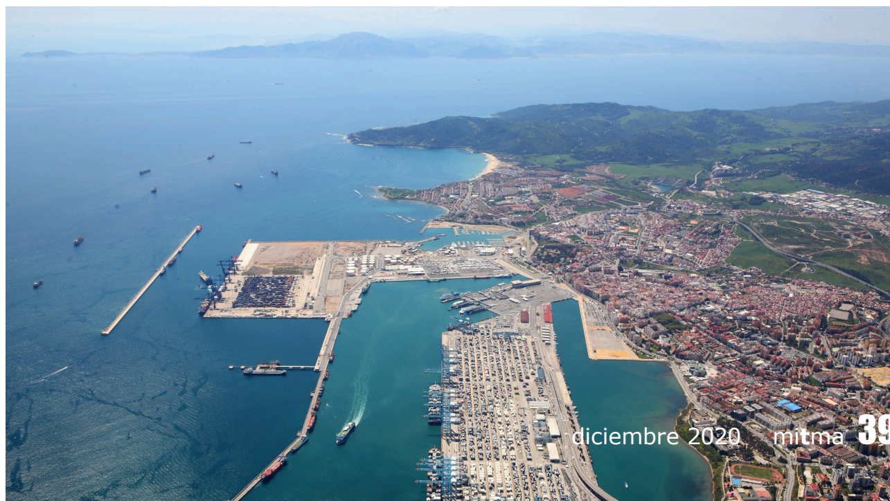
Vista aérea del Puerto de Algeciras.
